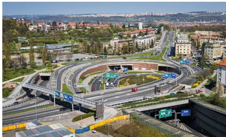
el túnel de Strahov a través de un puente sobre la calle Plzeňská y con las calles Plzeňská y Vrchlického a través de un paso elevado. Tiene dos entradas de tres carriles de circulación en cada sentido, en el lado norte hasta el cruce del túnel de Radlice; de ahí en adelante en dirección hacia el sur, solo tiene dos carriles en cada sentido.
