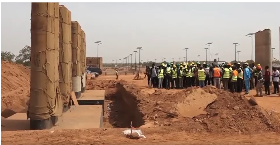
Visite du chantier des travaux d'élargissement et de modernisation de la RN04 à Ouagadougou le 10 mai 2025
