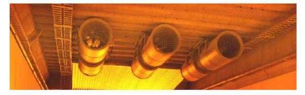
En el caso que se superen los niveles de CO y/o opacidad dentro de los túneles o en casos especiales, como frente a la ocurrencia de un incendio, por ejemplo, se activarán de manera automática los ventiladores y los extractores, para extraer el humo en éste último caso.
