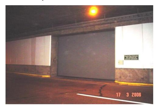
Cada 600 metros aproximadamente existen salidas peatonales de emergencia al exterior, con doble puerta de ingreso, amplias escaleras de escape y portones horizontales de accionamiento hidráulico en superficie. Tanto las puertas de conexión entre ductos como las de las salidas de emergencia tienen sensores de contacto, que permiten detectar en tiempo real si se encuentran abiertas o cerradas.
