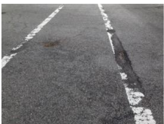
Immagine 18 : Esempi di problemi di segnaletica orizzontale e di manutenzione della segnaletica stradale [14]
