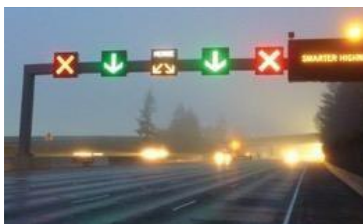
Immagine 7: Segnale di gestione dell'uso della corsia (LUMS, Lane Use Management Sign)
