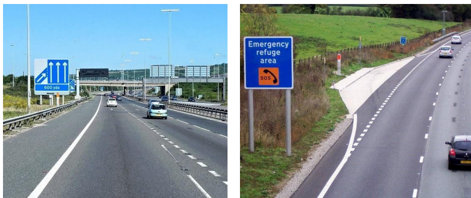
Immagine 13: Esempio di corsia di emergenza (sinistra) e di piazzola di sosta d'emergenza (destra)
