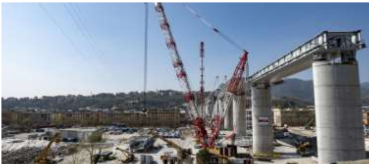
Ponte «Per Genova»
