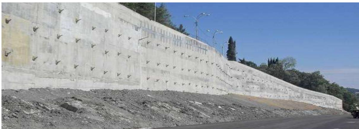
*Anclajes para la protección de deslizamiento en el área de intercambio de la ciudad de Sochi (© Rosasfalt)*
