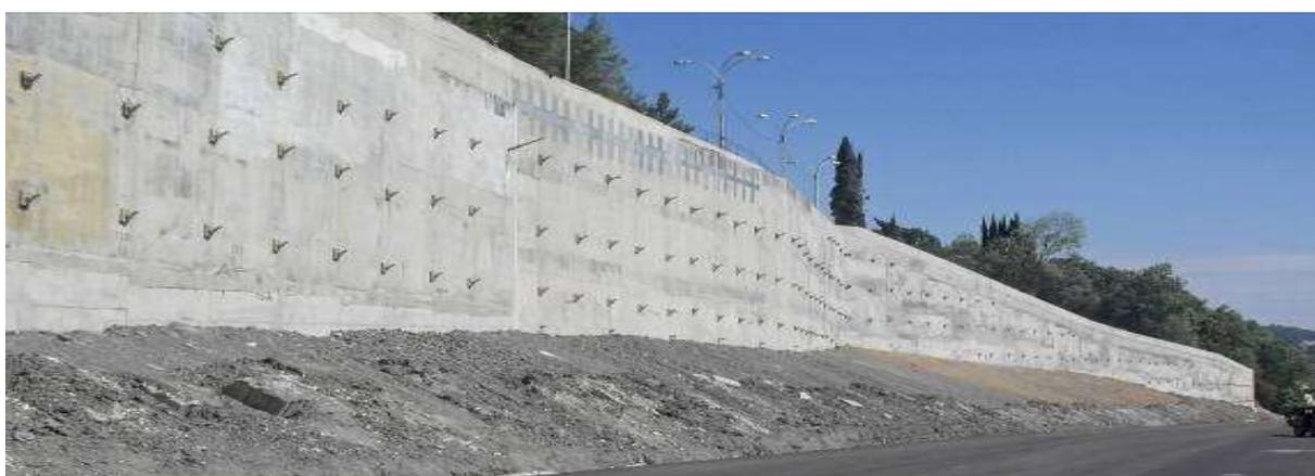
*Structure de protection contre les glissements de terrain, par ancrage et mur de soutènement, zone d'échangeur à l'entrée de Sochi (© Rosasfalt)*
