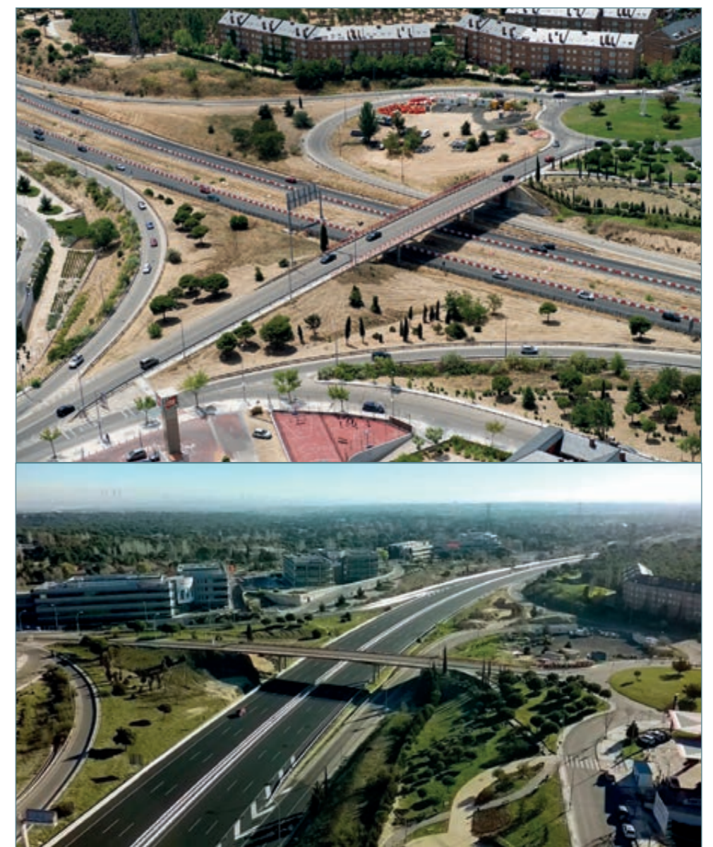
La M-503, entre Pozuelo y Majadahonda, durante su construcción y finalizada la actuación
