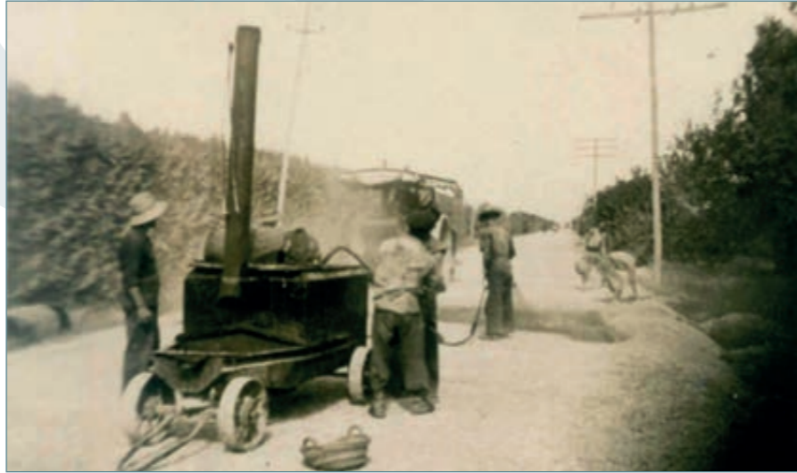
Ejecución del riego de betún asfáltico en la carretera de Alzira a Favara. Año 1946 (Fuente: Diputación de Valencia).
