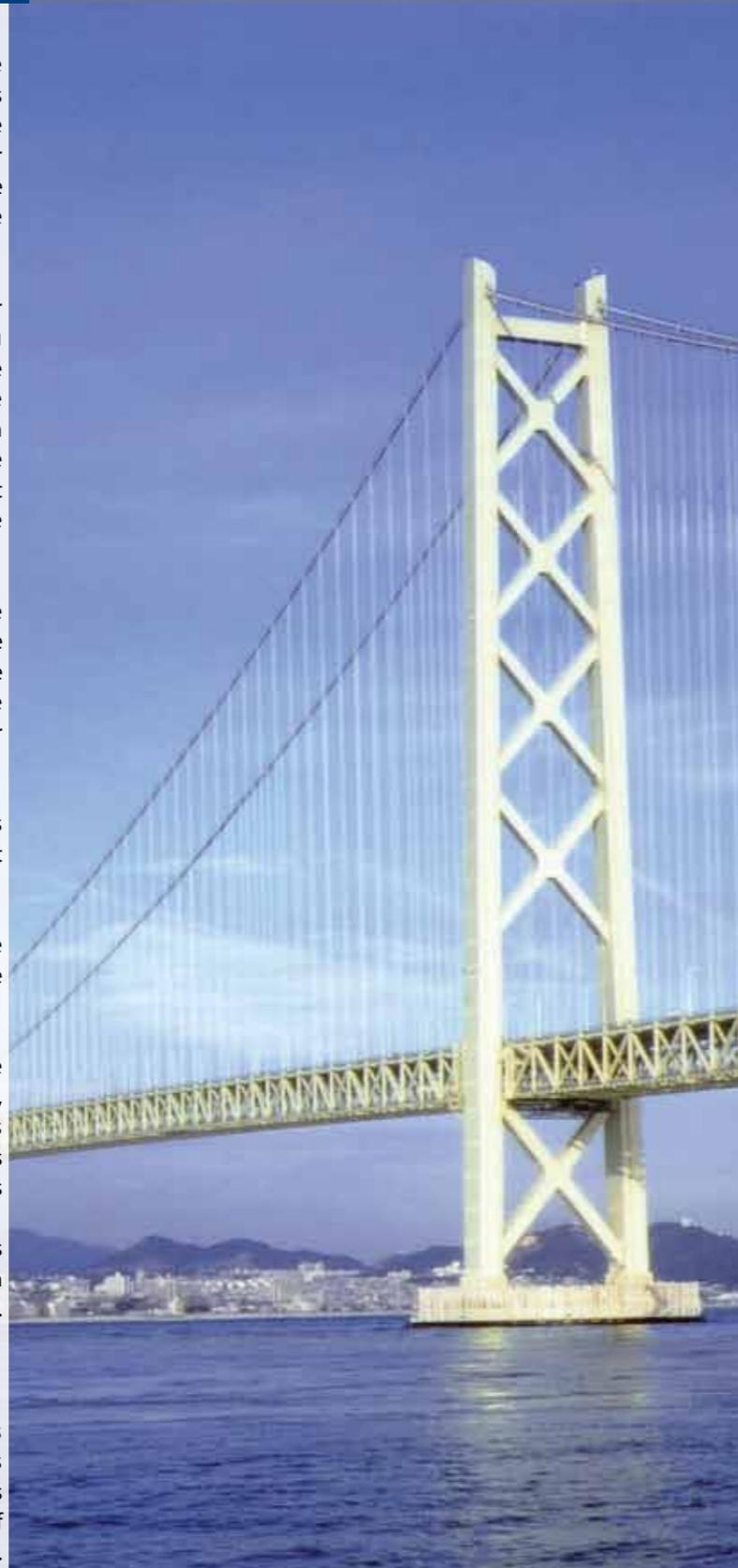
Photo 3 - Le pont Akashi Kaikyo possède la plus grande travée centrale suspendue (1 991 m), ainsi que des caractéristiques innovantes pour répondre à des contraintes de gestion élevées © HSBE
