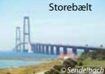
Storebælt                           | Danemark | Pont Est : 6 790 m, troisième plus grand pont suspendu du monde (travée centrale de 1 624 m), poutre caisson en acier<br>Pont Ouest : 6 611 m, poutre caisson en béton, travée de 110 m<br>Date de construction : 1998                                                                                                                                                                   |
