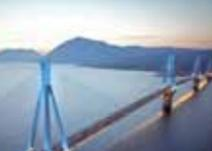
Charilaos Trikoupis (Rion-Antirion) | Grèce    | Pont Charilaos Trikoupis (ancien pont Rion-Antirion) reliant la Grèce continentale au Péloponnèse<br>Pont principal multi-haubané, constitué de 3 travées de 560 m et de 2 travées de rive de 286 m ( <i>photo 2, page suivante</i> )<br>Tablier composite : poutres en acier, dalle en béton<br>Date de construction : 2004                                                             |
