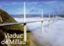
Viaduc de Millau                    | France   | Pont à haubans à travées multiples<br>Travée de 342 m, longueur totale de 2 460 m<br>Poutre caisson en acier<br>Date de construction : 2004<br>( <i>photo 1, page de droite</i> )                                                                                                                                                                                                        |
