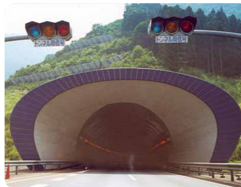
Entrée du tunnel de Kanetsu (Japon) Entrance to the Kanetsu Tunnel (Japan)
