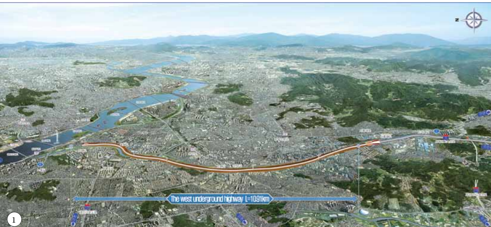
Figure 1 – Vue d'ensemble du tracé du tunnel Figure 2 (page de droite) – Accès à la gare de péage Geumcheon
