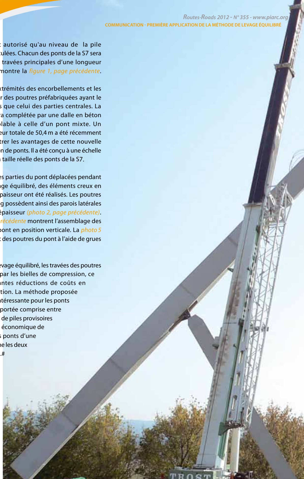
Photo 5 - Abaissement des poutres du pont à l'aide de grues mobiles
